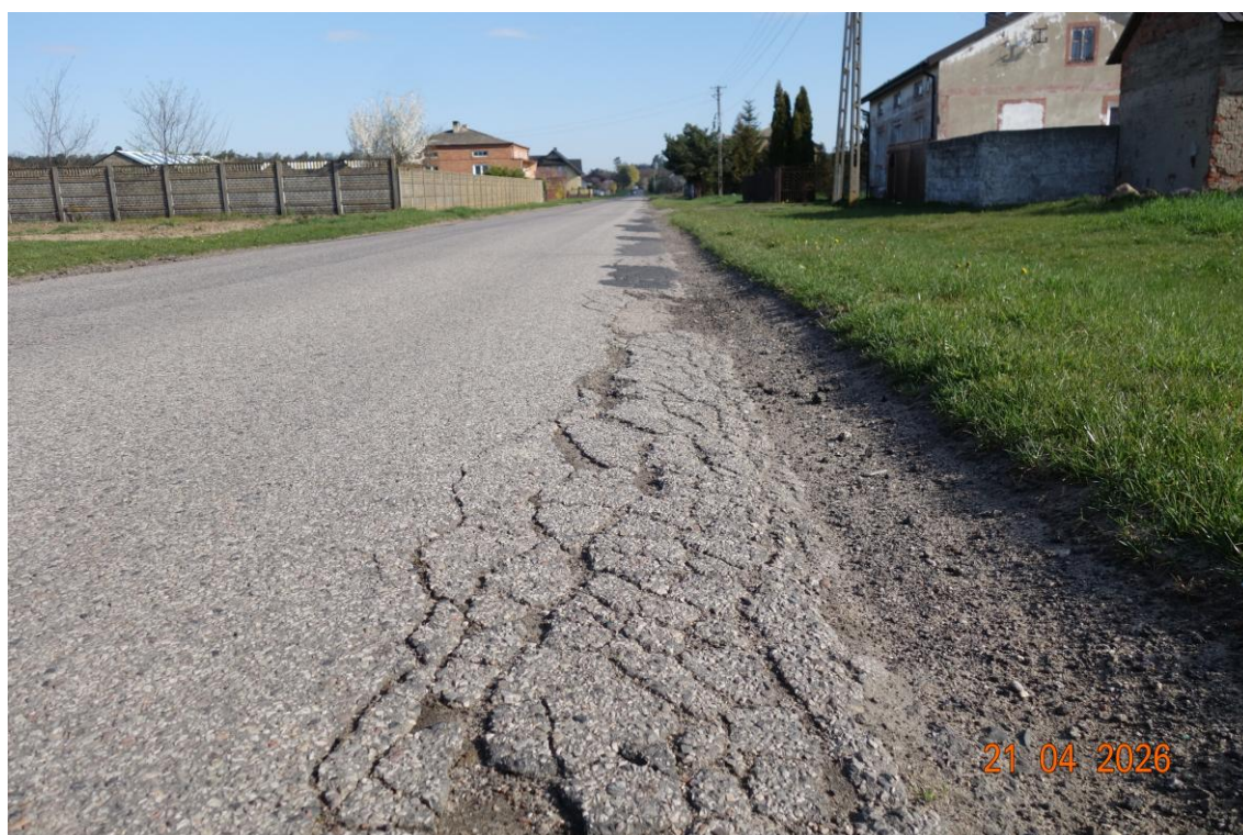
Nr 4. Widok na typowe uszkodzenia nawierzchni o charakterze ciągłym i zawyżone pobocza.
