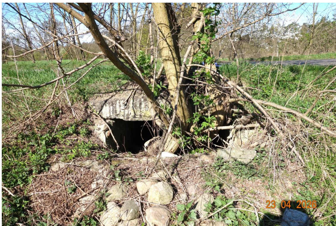
Nr 14. Uszkodzony przepust w km 0+893.80 do wymiany - wyrastające z wlotu samosiewy
