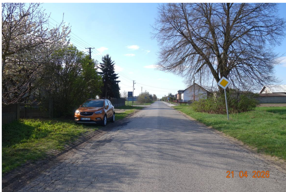
Nr 4. Widok na typowe uszkodzenia nawierzchni o charakterze ciągłym i zawyżone pobocza.
