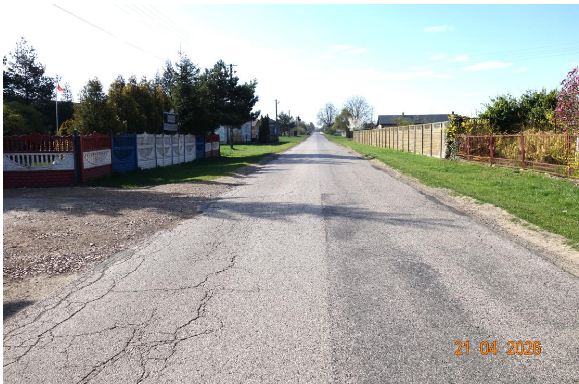
Nr 6. Widok z km 0+300 w kierunku Budziszewic, widoczne spękania jezdni
