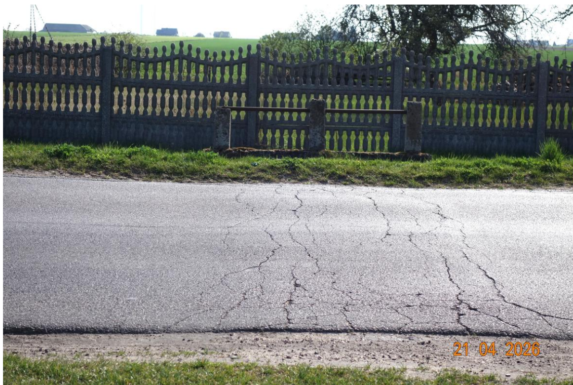
Nr 10. Uszkodzenia nawierzchni na przepuście z fot. Nr 7.
