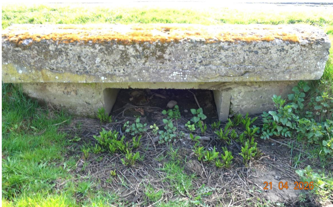
Nr 8. Pozostałości bariery na przepuście z fot. Nr 7 (wlot)
