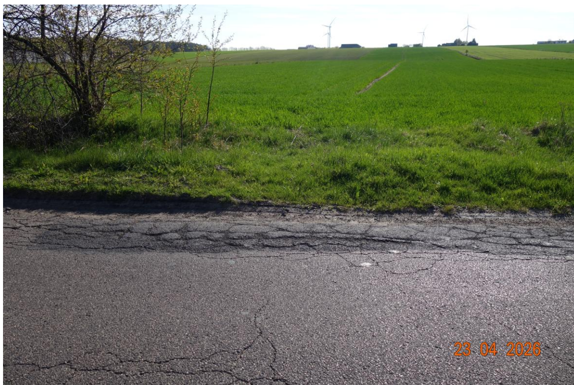
Nr 12. Przetłomy w pasie przy krawędzi nawierzchni - dotyczy całego odcinka
